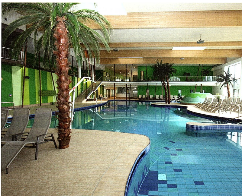
Das Hallenbad Bambados in Bamberg. Eine Innenansicht. Bild: Passivhaus-Institut
